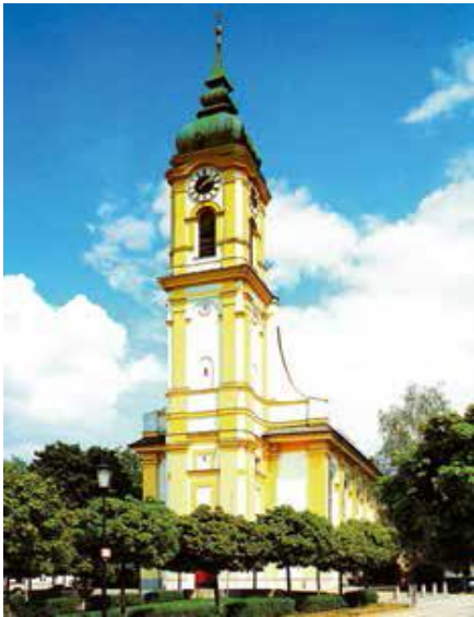
St. Michael nach der Renovierung Sommer 1979
