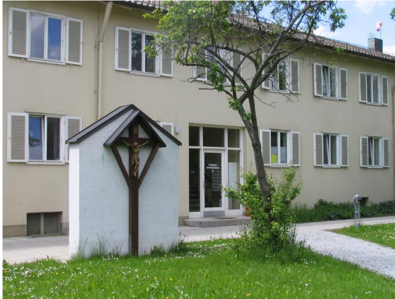
Die Kreuzwand vor dem Personalgebäude I der HELIOS Klinik in Perlach 1
